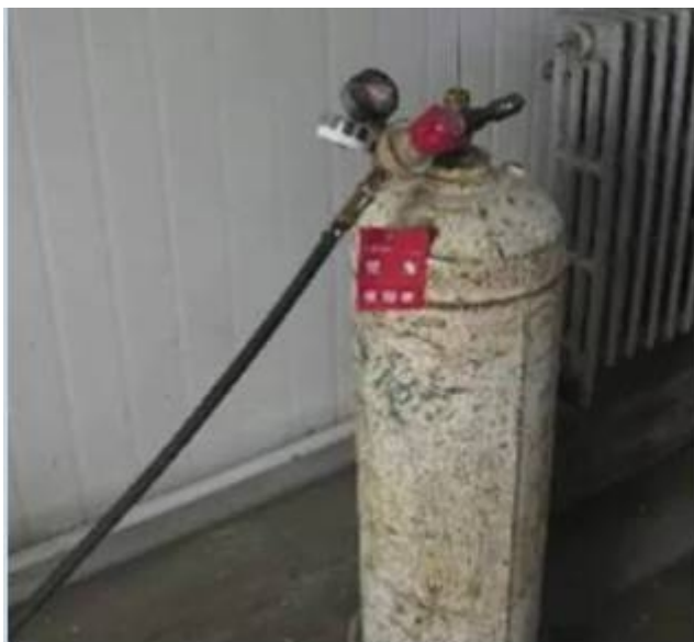
① 气瓶无固定 胶圈不全
